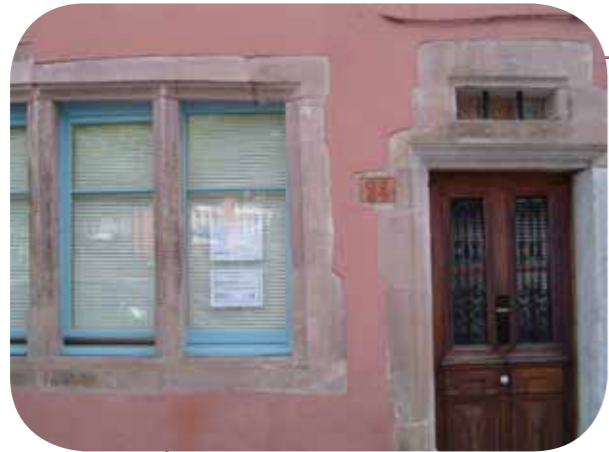
Exemple d'une fenêtre à meneaux, N°24 Rue Diemer-Duperret
