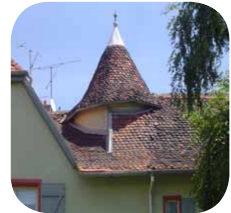
Yorbe du N°4 de la rue de la Sous-préfecture
