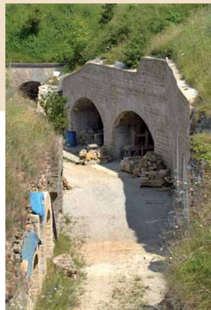
Vue d'une partie du fort récemment restaurée.
