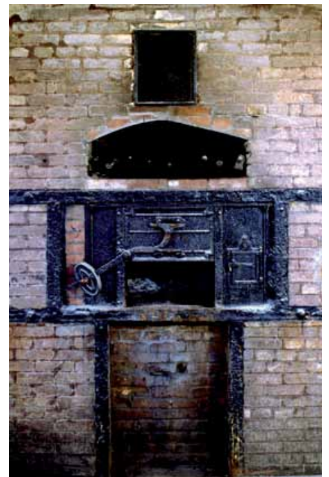
Le four Lespinasse, encore en état de fonctionnement.
